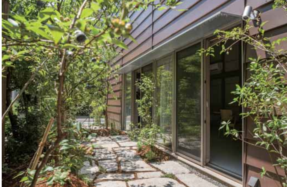
庭1(住居A)より東側外壁を見る。塗装ガルバリウム鋼板を用い、古くから多用されている「鍍張り」で仕上げている。
