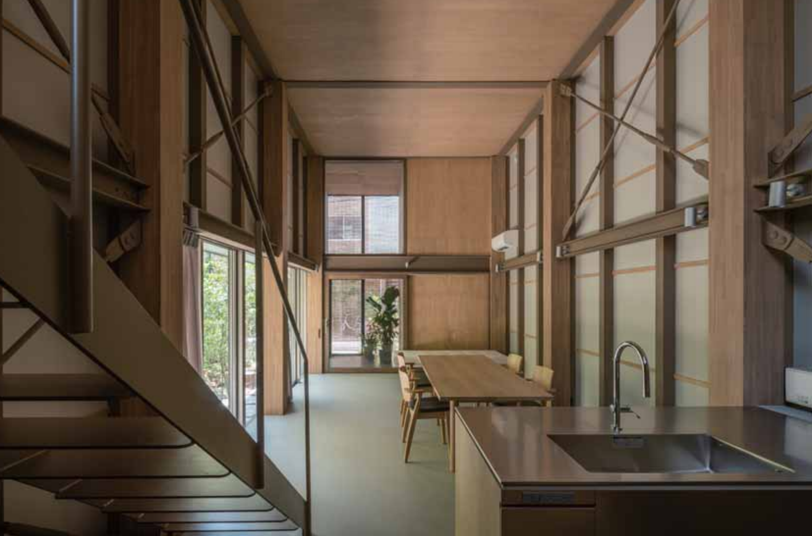
住戸Aの室1階段奥より道路側(南)を見る。奥行のある天井の高いがらんだ空間は、外装材と同じカラートーンに併せた下地鉄骨が木造軸組を想起させる。
