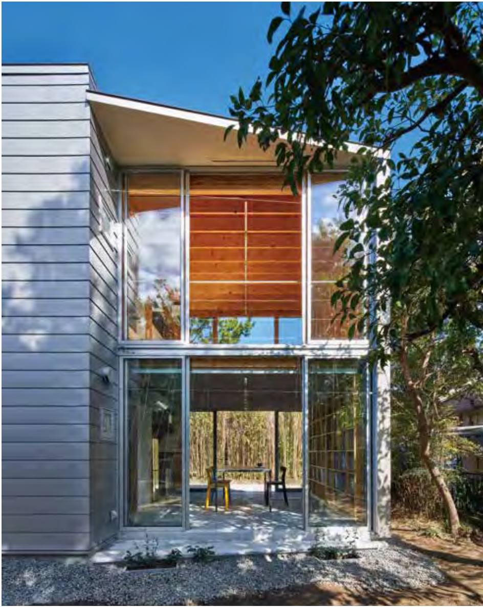
南側外観。今は生えそろうた緑化カーテンと庇で南側の厳しい日射を遮っている。
