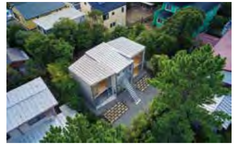
北側俯瞰。3つのボリュームがはっきりと分かる。
