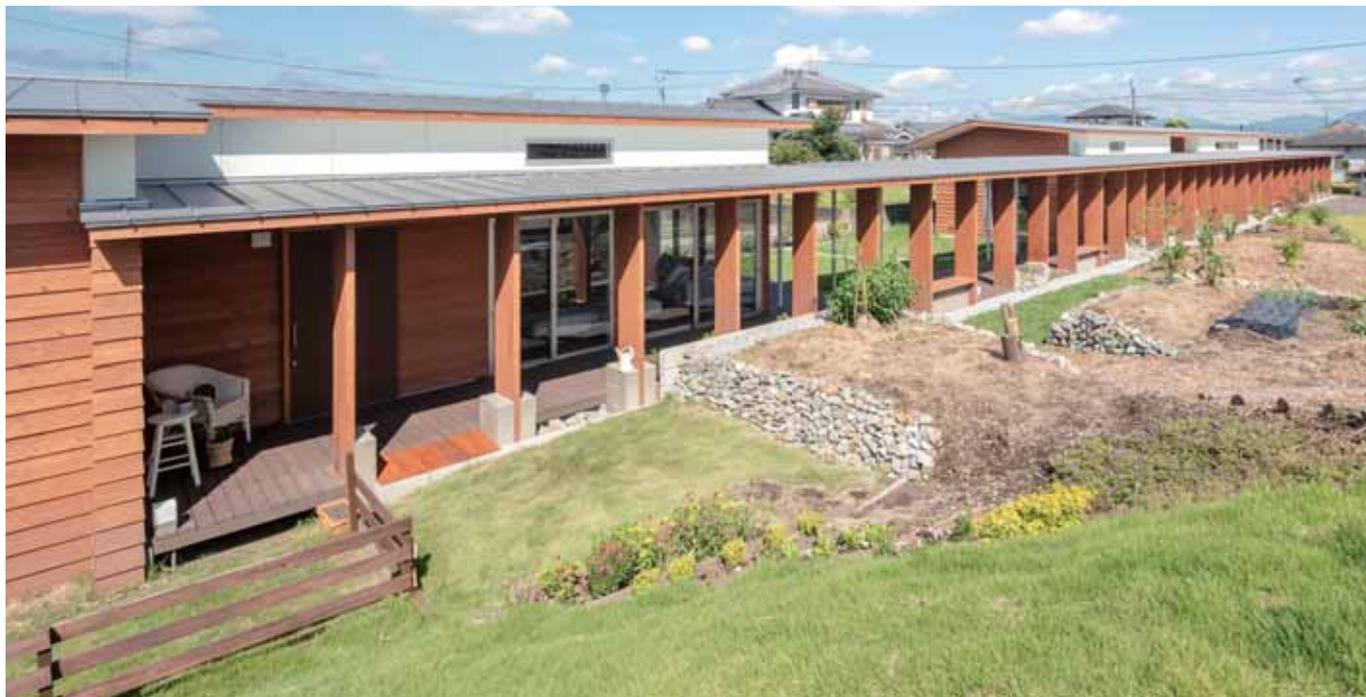
1,365~1,820ミリピッチで並ぶルーバー壁が塗装ガルバリウム鋼板屋根を支える。
